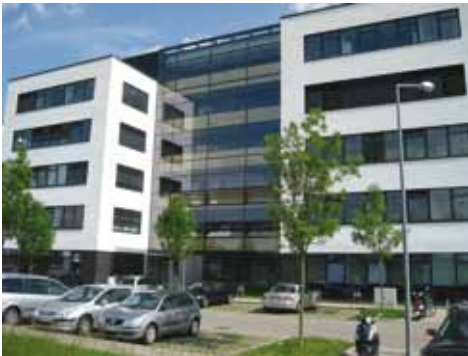
Abb. 1 Bürogebäude (Quelle: ebök)
