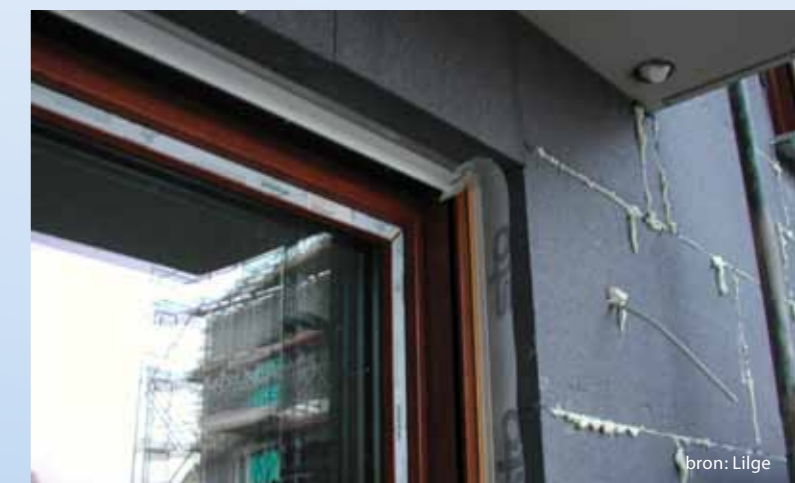
Massieve bouw – muur met isolatie-kozijnbouw
