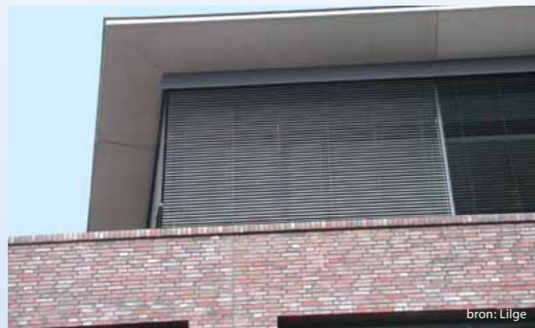
Zonwering van een glazen gevel door lamellen
