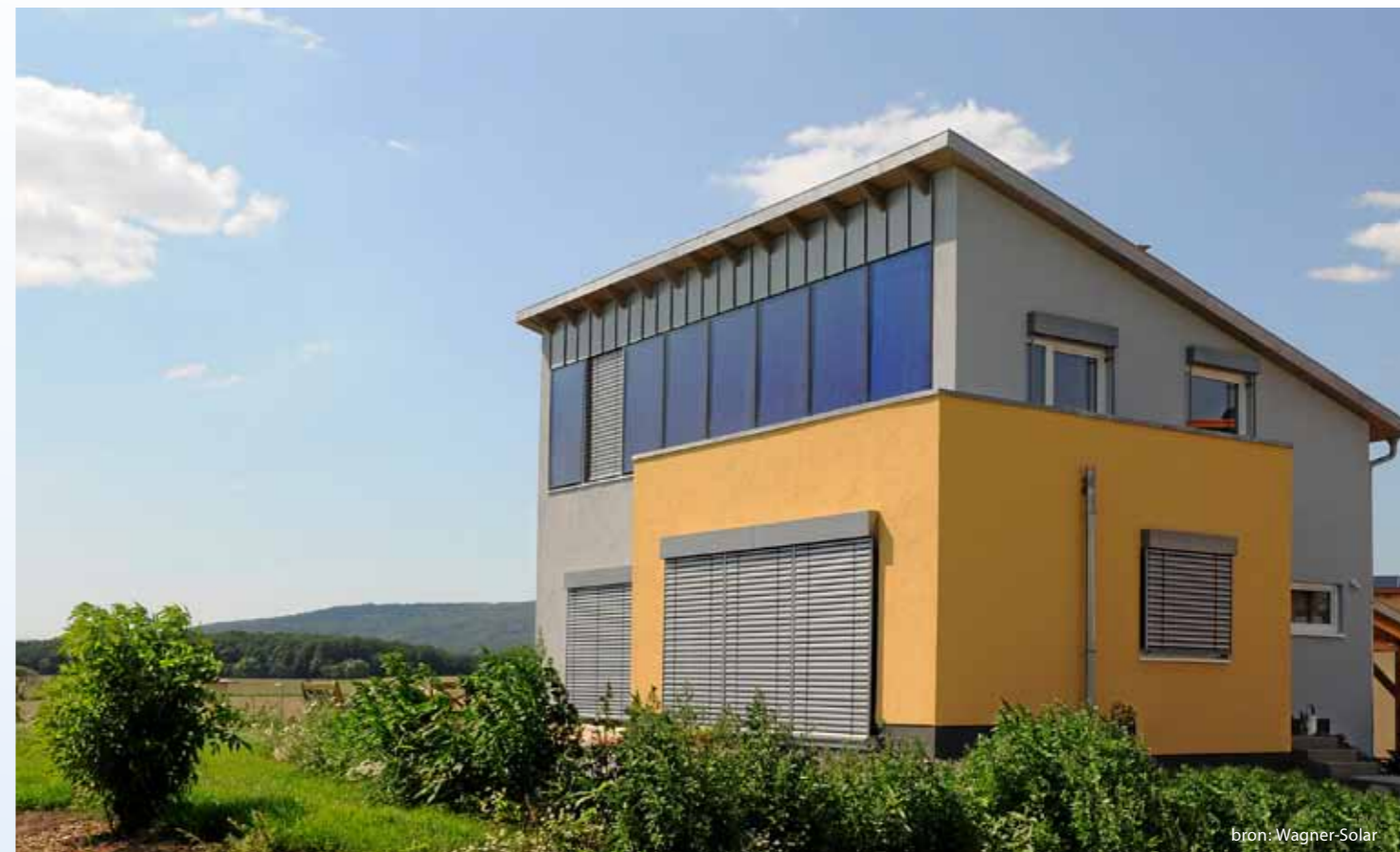
In de gevel geïntegreerde zonnecollectoren
