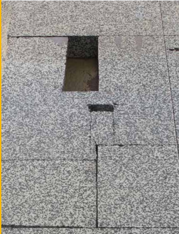
Een goede gesloten uitvoering van de isolatie – zonder gaten of spleten – is niet alleen bij passief huizen van belang
