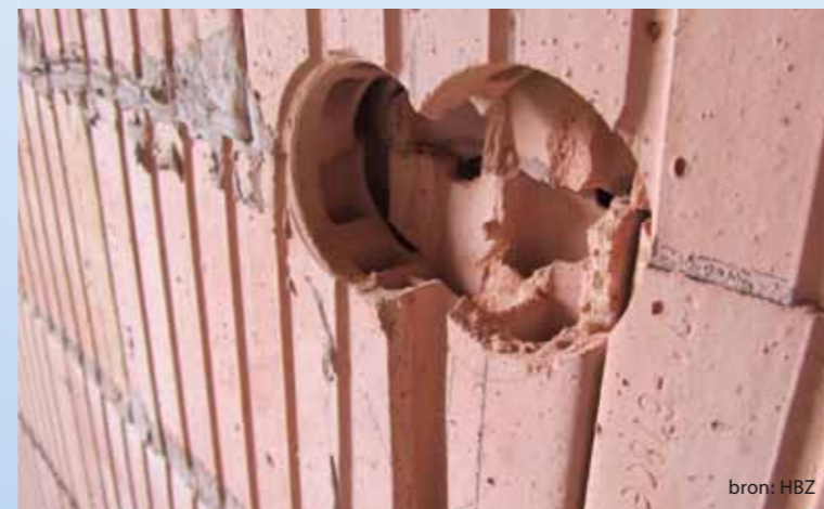
Zonder afdichting zal uit dit stopcontact ongecontroleerd lucht stromen.
