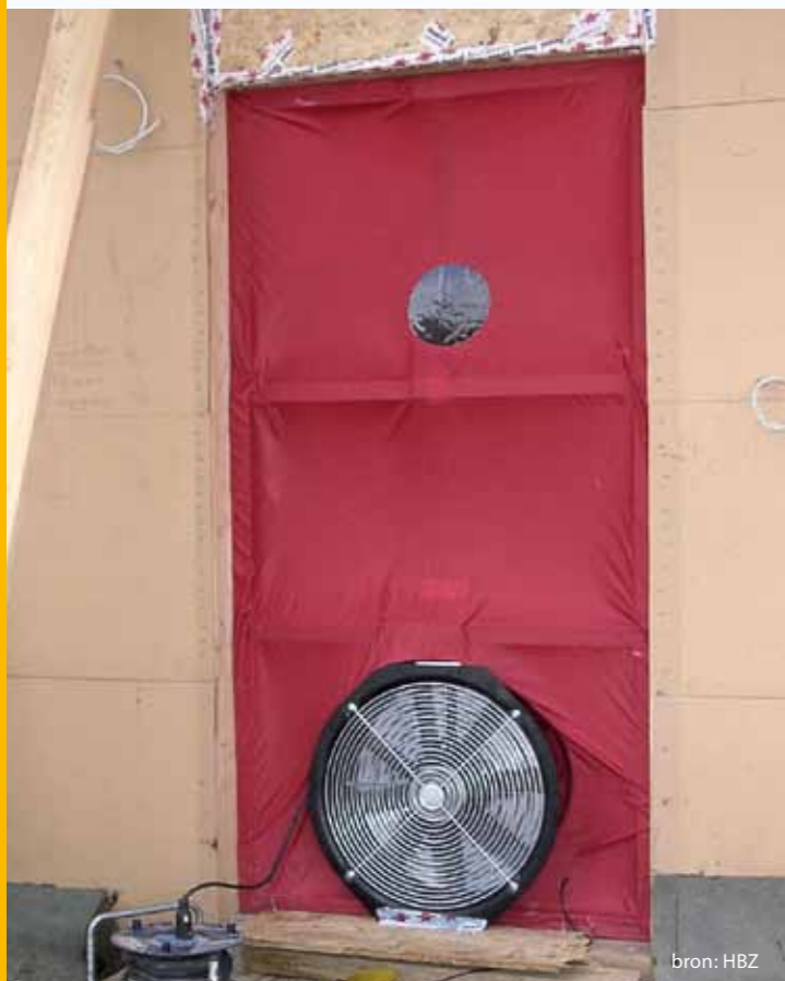
Blower-door-test tijdens de bouw om eventuele lekkage op te sporen
