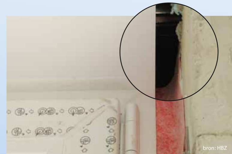
Bij een intensieve controle van de bouw kunnen fouten op tijd worden herkend en met relatief weinig kosten worden hersteld.
