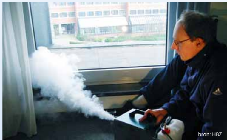
Gebruik van het nevelapparaat om de vensteraansluitingen te controleren
