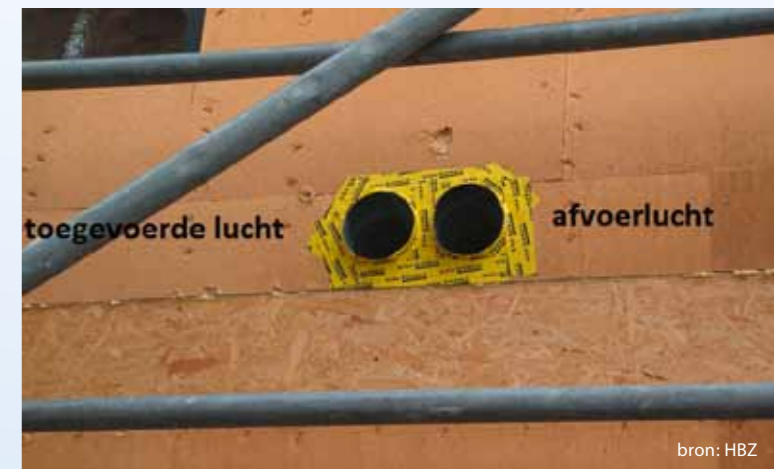
Bij een intensieve controle van de bouw kunnen fouten op tijd worden herkend en met relatief weinig kosten worden hersteld.
