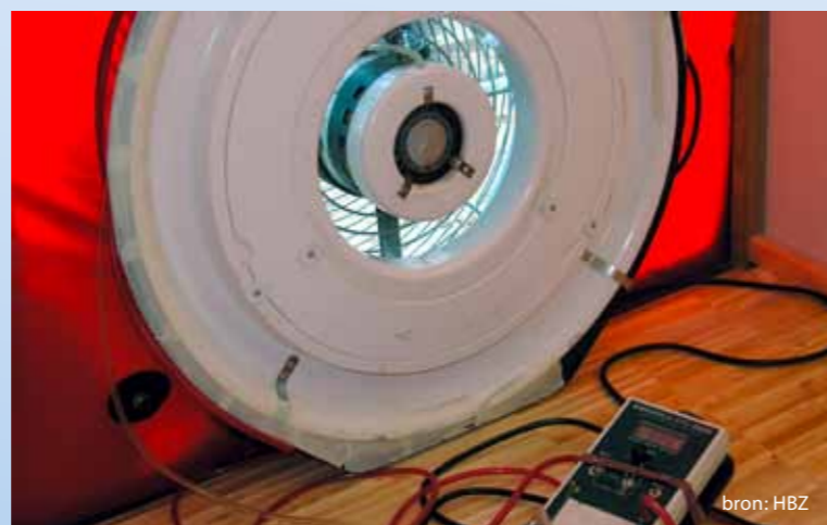
Blower-door-ventilator met meettoestel om de volumestroom te meten
