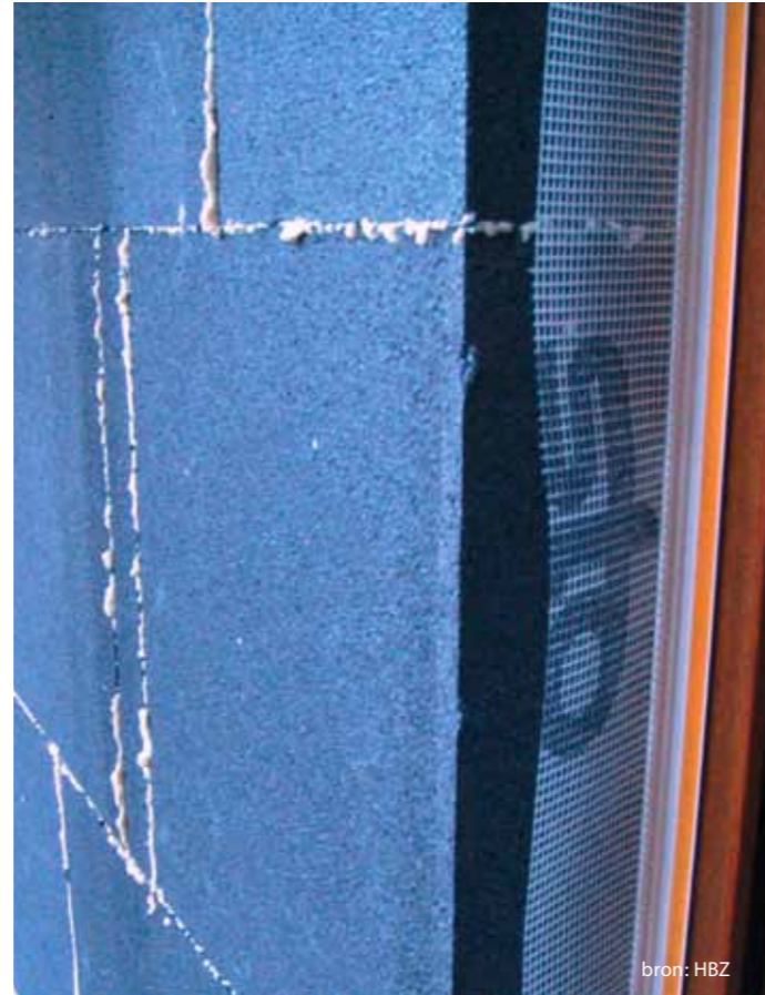
Een goede gesloten uitvoering van de isolatie – zonder gaten of spleten – is niet alleen bij passief huizen van belang
