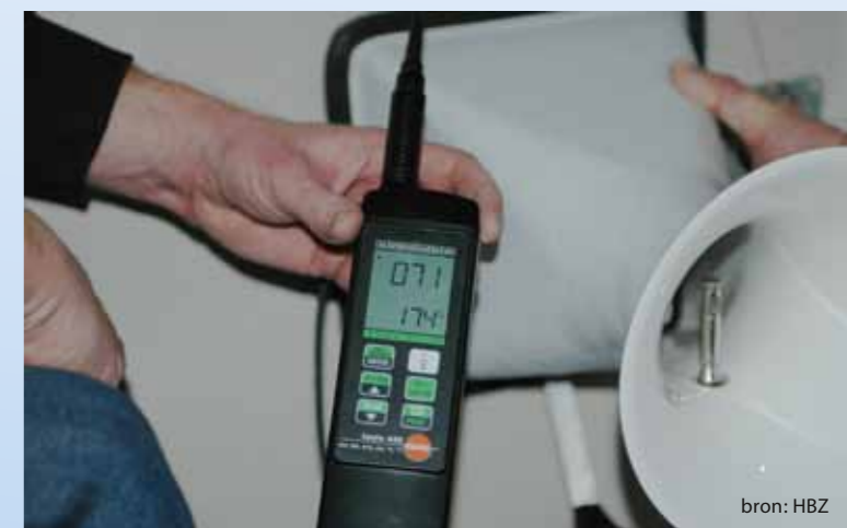
Debietmeting bij een stopcontact met thermische anemometer en volumestroomtrechter
