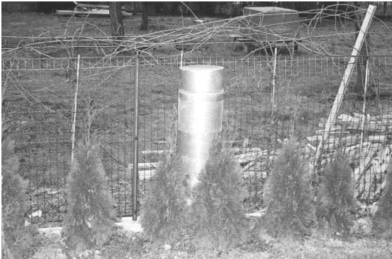
Abb. 5: Anordnung des Außenluftdurchlasses eines LEWT unmittelbar neben Vegetation (Tappler 2005)
