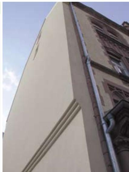
Abb. 43. gelungener Absatz der Dämmebene zum unbeheizten Treppenhaus
