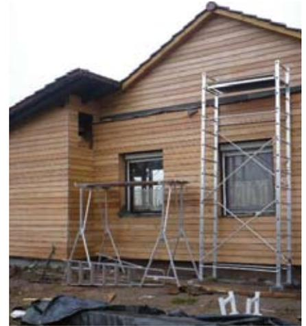
Abb. 36. Fertige Fassade mit Lärchenholz (Keilspundprofil). Oben sichtbar die Dachpappe, zum vorläufigen Schutz der Verbreiterung der Wand.
