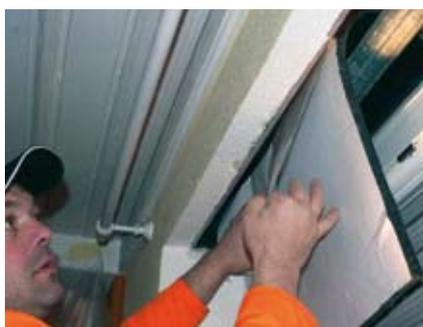
Abb. 27. Einbau einer 20 mm starken Dämmplatte
