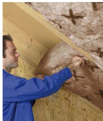
Abb. 17. Untersparrendämmung
