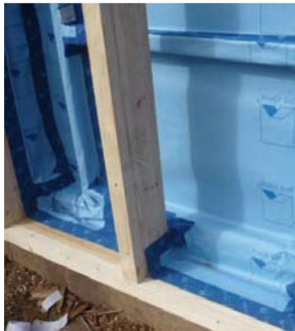
Abb. 37. Detail der Verklebung. Gut sichtbar: Dämmung geht bis unter die Fußboden-Ebene.
