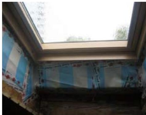
Abb. 18. Beispiele für luft- und winddichte Anschlüsse
