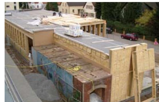
Abb. 60. Flachdachdämmung
