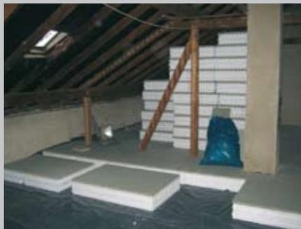
Abb. 19. alter Dachboden und Deckendämmung im Bau
