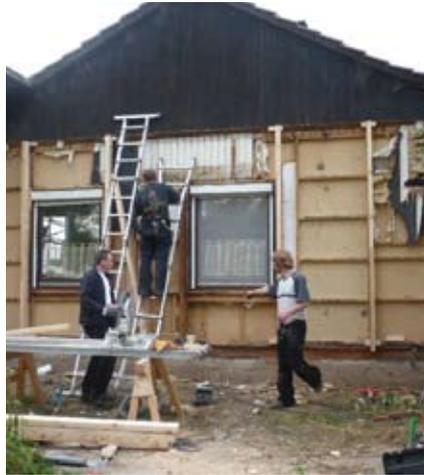
Abb. 35. Komplett entkernt. Sichtbar ist die Skelett-Konstruktion und oben ein Rest der alten weißen Holzverschalung.
