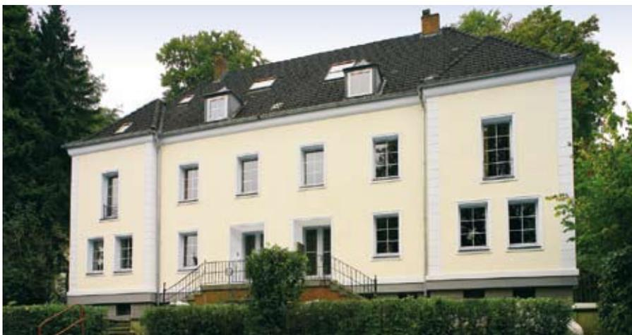
Abb. 12. Erhöhung des Gestaltungswertes durch Einsatz des Wärmedämmverbundsystems
