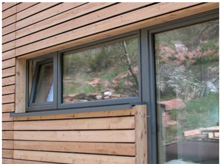
Abb. 45. Drei-Scheiben-Wärmeschutzverglasung
