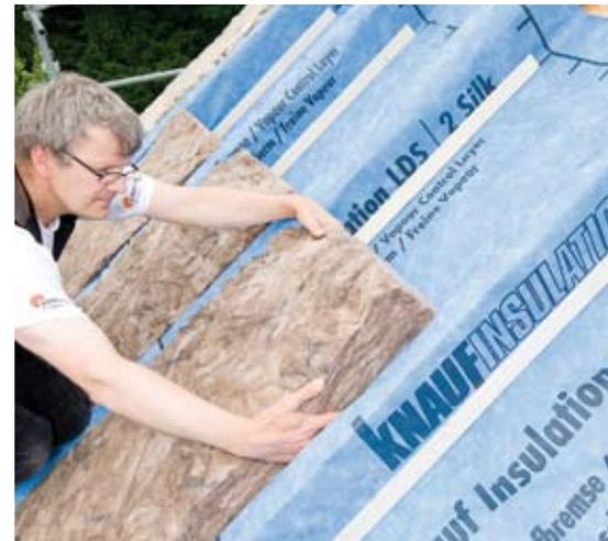
Abb. 14. Zwischensparrendämmung
