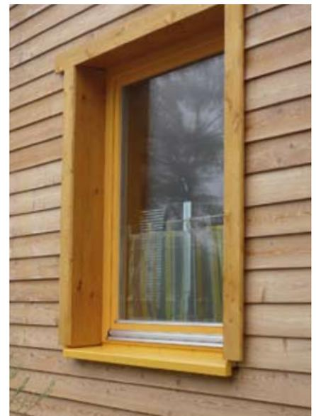
Abb. 39. Fassade mit neuen Energie-Sparfenster, U-Wert 0,5.
