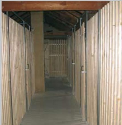
Abb. 20. Dachboden mit begehbarem Belag und neuen Verschlagen, saniertes Zustand
