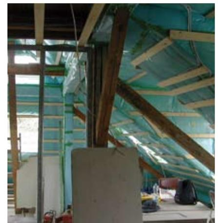
Abb. 47. Die luftdichte Ebene ist noch sichtbar (Folie und Holzbauplatte): Der optimale Zeitpunkt für eine Blower-Door-Messung
