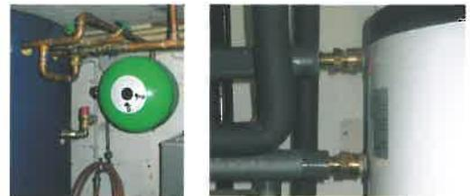
☹ *Schwachstellen: Speicheranschlüsse mit hohen Wärmeverlusten.*
