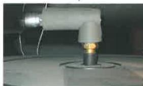
☹ *Kritisch: Warmwasseranschluss nach oben und schlecht gedämmt.*
