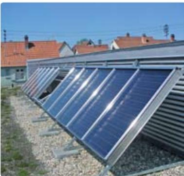
**Solarthermie:** Thermische Solaranlagen nutzen die Sonnenenergie zur Warmwasserbereitung. Die Voraussetzungen dafür sind sehr günstig, da der Warmwasserbedarf eines Haushaltes über das Jahr annähernd konstant ist. Mit einer richtig dimensionierten Anlage kann man jährlich 50 bis 65 Prozent des Warmwasserbedarfs mit Sonnenenergie decken. Im Sommer kann meistens
